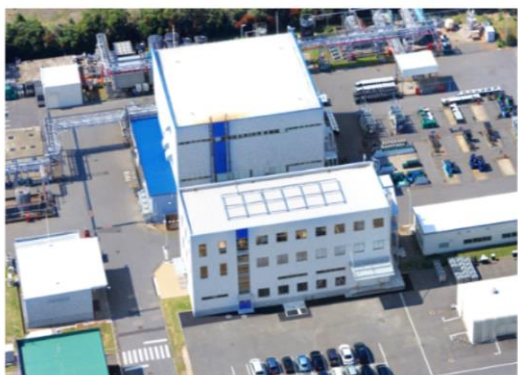
* 旭工場外観 (千葉県旭市)
