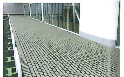
▶ ステンシルを撤去して完成
