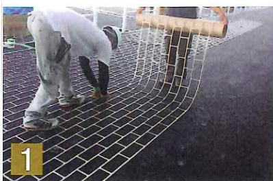
1 ステンシルペーパーを施工面に敷く
