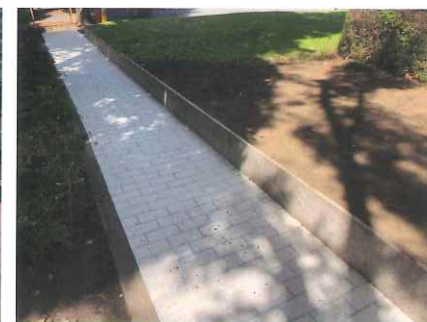
写真④ 「リリーフペイント」施工後の東京都国立市・国立市役所内歩道
