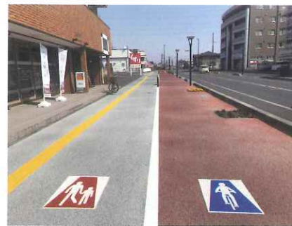
写真③ 「リリーフペイント」を施工した埼玉県北本市の歩道・自転車道
