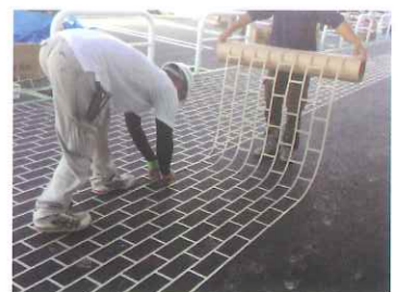
「リリーフペイント」スプレーステンシル工法の作業風景
