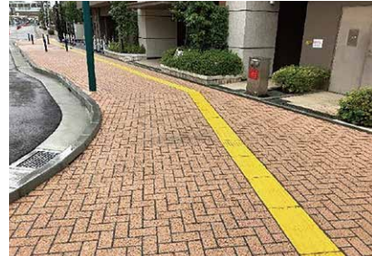
▲東急武蔵小杉駅側の歩道。新設するルートではあるが、元々のまちの景観になじむような色合いと柄を選定した。
