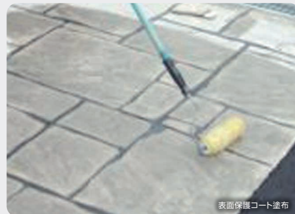
混合物を吹付け
