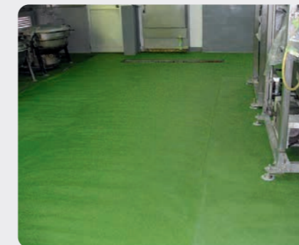
食品工場施工例(防滑グリーン)
