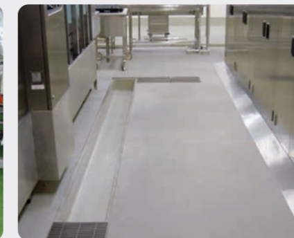
病院厨房施工例(防滑グレー)
