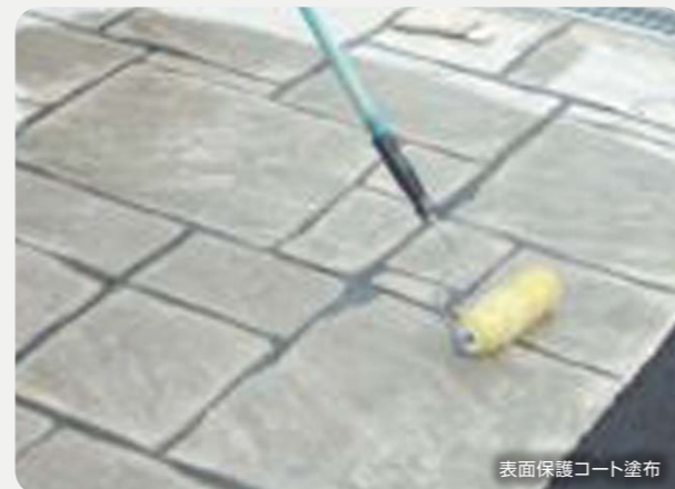
混合物を吹付け
