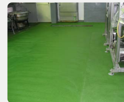
食品工場施工例(防滑グリーン)
