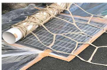
マスキングテープと養生シートで保護 排水溝やマンホールなども丁寧に養生
