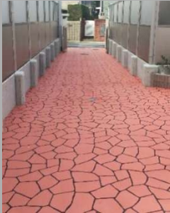
スプレーステンシル工法 施工例
