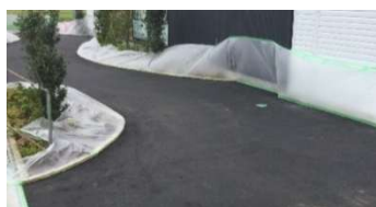
マスキングテープと養生シートで保護 排水溝やマンホールなども丁寧に養生
