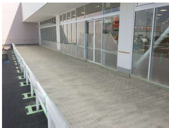
上塗り1層目吹付け終了
